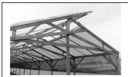
Invernadero Quillotano denominado: tipo capilla o de lucarna dos aguas.
